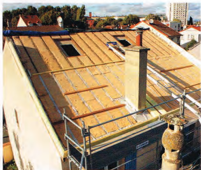
© SYLVAIN DUCROCCO/TOITURES DE L'ORANGERIE
